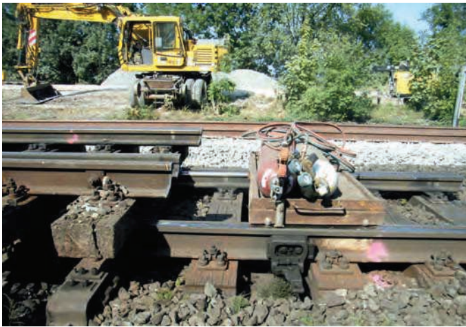
Abb. 2: Beim Brennschneiden der Altschienen entsteht Wärmeeinwirkung auch auf die Holzschwellen (worst-case-Fall für PAK-Freisetzung) (Foto: BG BAU Prävention)
