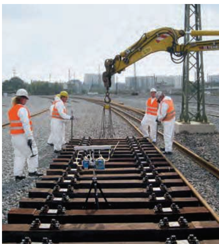
Abb. 4a, b: Analyse der Luft im Arbeitsbereich beim Verlegen von Neuschwellen (links) und Messgerät zur Luftanalyse unmittelbar über der Schwellenoberfläche (unten) (Fotos: BG BAU Prävention)
