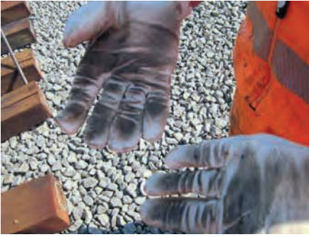
Abb. 5: Durch Holzschutzmittel aus Neuschwellen verschmutzte, ungeeignete Lederhandschuhe (Foto: BG BAU Prävention)
