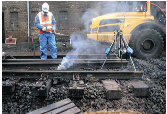
Abb. 3: PAK-Luftmessungen bei Brennschneidearbeiten an Jochen mit Altschwellen (Foto: BG BAU Prävention)
