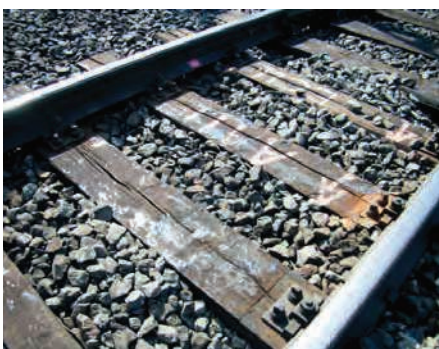
Abb. 1: Beim „Ausschwitzn“ von Imprägnierungsbestandteilen durch hohe Temperaturen können Geruchsbelästigungen auftreten (Foto: BG BAU Prävention)
