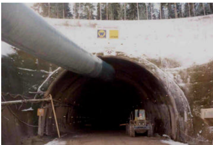
Abbildung Sprengvortriebarbeiten in einem belüfteten Tunnel
