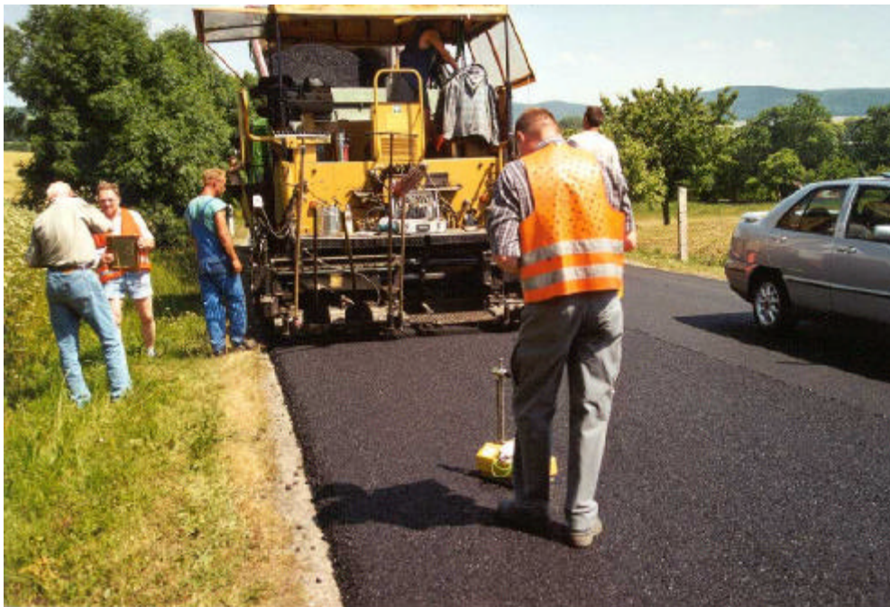
Abbildung 2-40: Bitumenverarbeitung im Straßenbau
