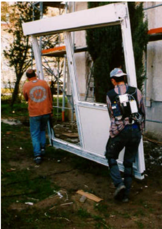
Abbildung Einbau von Fenstern, Erfassung der Körperbewegung und der Lastgewichte mit dem Messsystem CUELA-HTR
