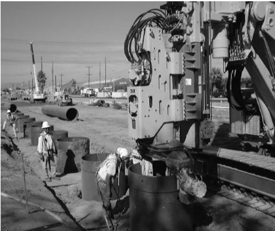
Abbildung 2-32: Einsatz eines Vibrators für Spundwände
