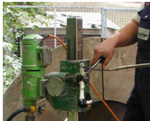
Abbildungen: Erstellung von Kernbohrungen mit und ohne Führungsgestänge
