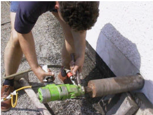
Abbildungen: Erstellung von Kernbohrungen mit und ohne Führungsgestänge
